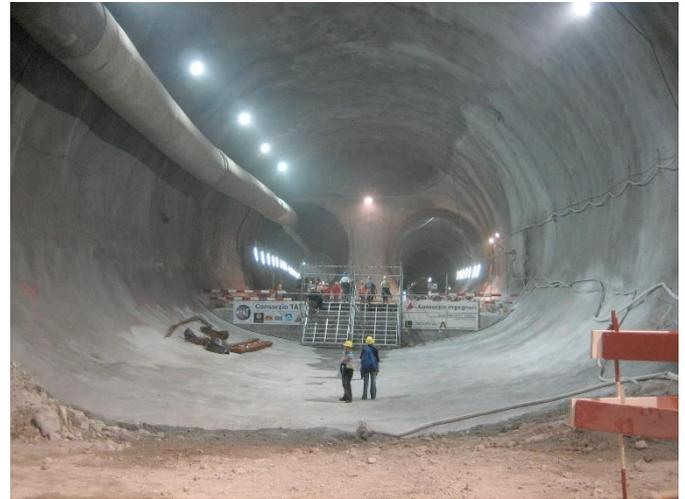
Imagine o problema que seria se as duas frentes não se encontrassem! Os processos utilizados para garantir o atendimento ao escopo do projeto, como a utilização de laser para identificação de nivelamento do túnel, tendo como diferença final um desnível de apenas 2 cm no encontro das duas máquinas, fez com que a etapa de controle do projeto também fosse bem executada.
